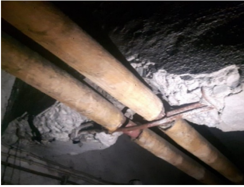
c) Tesisat geçirilen betonarme kiriş
