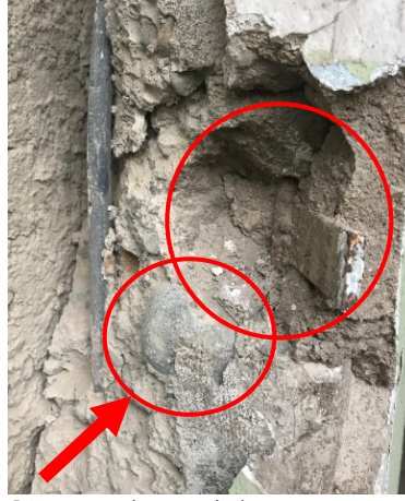
b) Granülometri dışı agrega ve zarar verilmiş kolon
