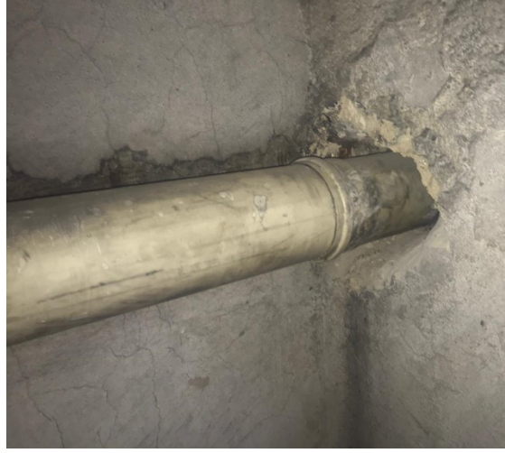
b) Tesisat geçirilen betonarme perde
