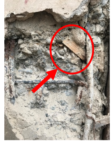
c) Yabancı malzeme (ahşap)
