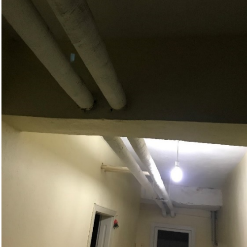
a) Tesisat geçirilen betonarme kiriş
