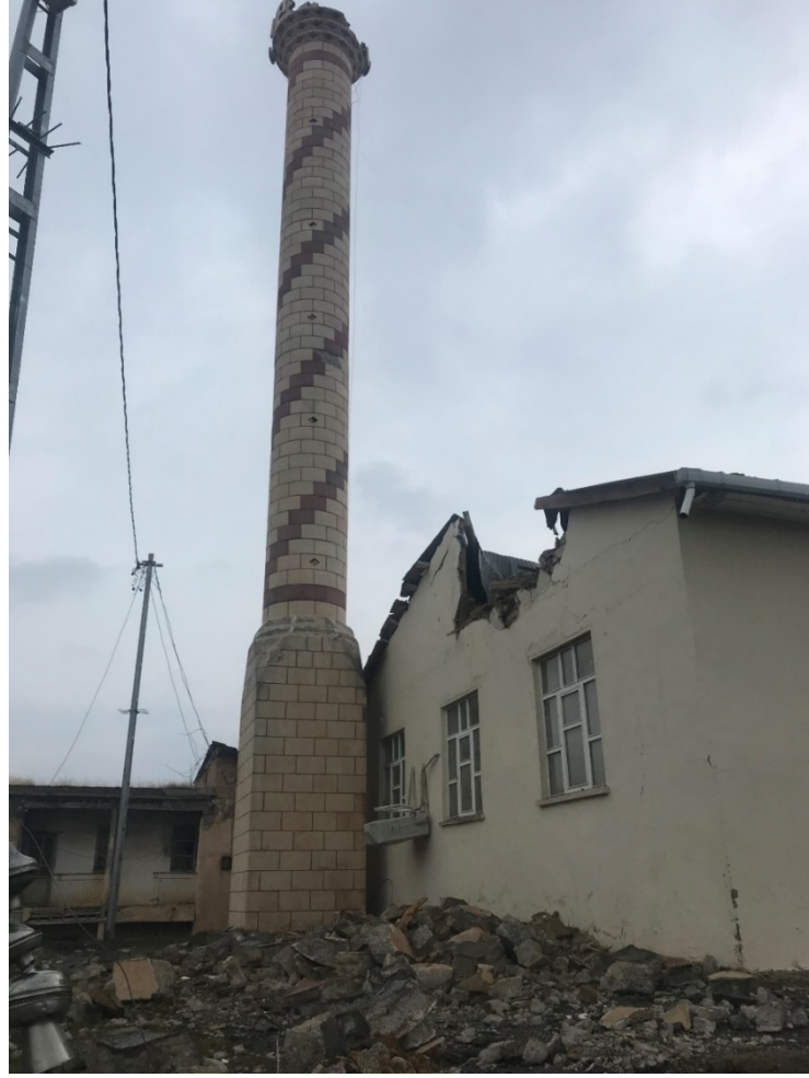
Şekil 5.11. Şerefe kısmından yıkılmış minare örneği
