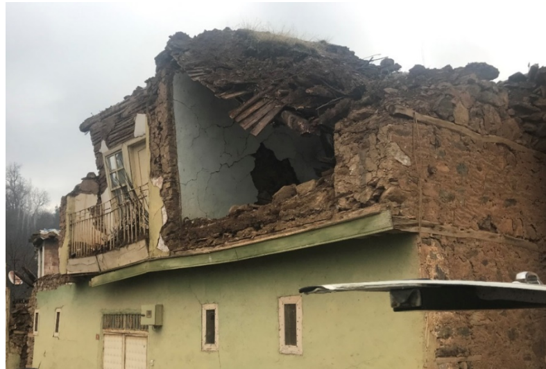
Şekil 5.3. Ağır toprak çatılı yığma yapı hasarı
