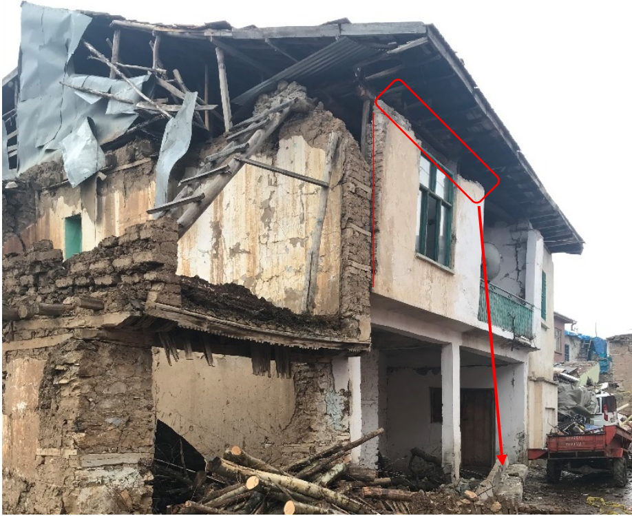
Şekil 5.6. Kerpiç yapı enkazı
