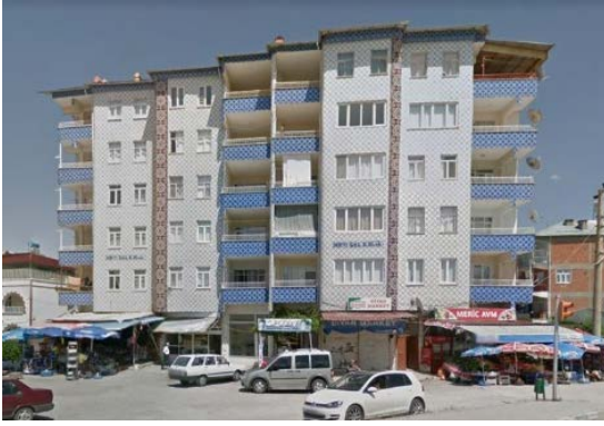
a) Deprem öncesi
