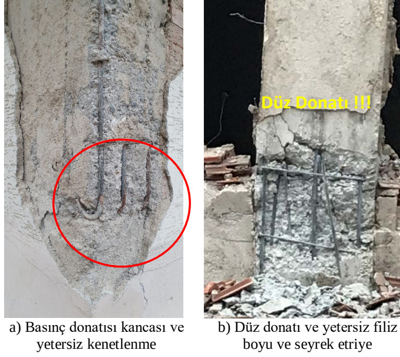
Şekil 4.7. Donatı uygulama hataları
