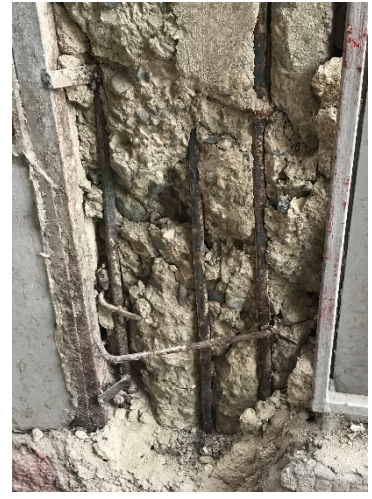
c) 90° kancalı etriyenin açılması ve yetersiz işçilik
