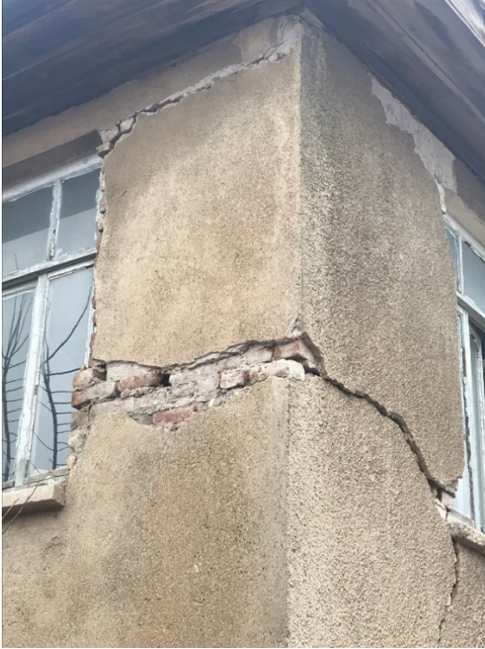
b) Yatay derz kırılması
