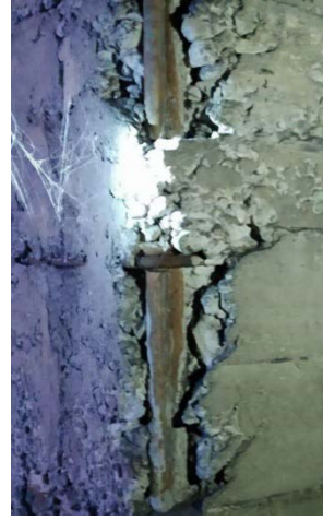
d) Tesisat geçirilen betonarme kolon
