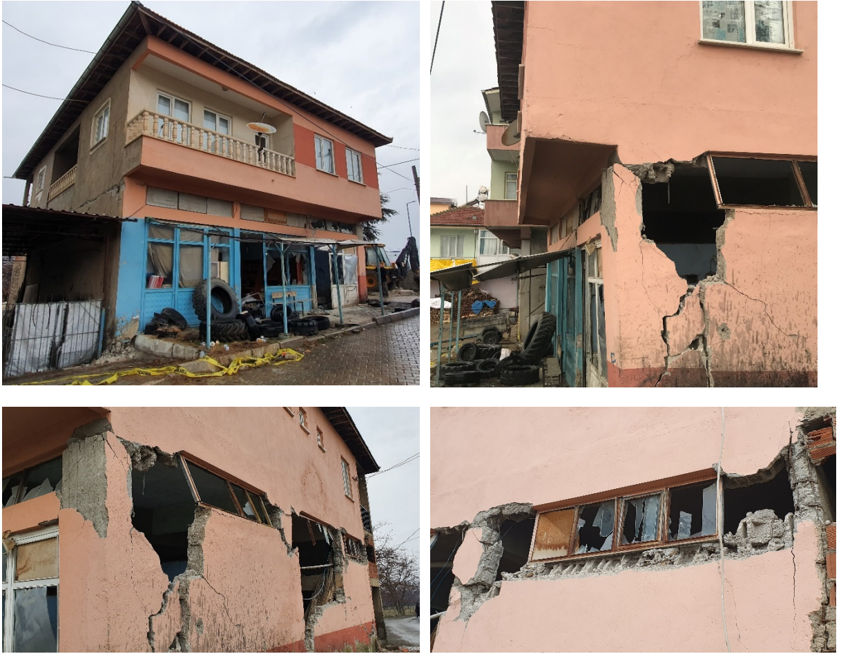
Şekil 4.9. Malatya Doğanyol dükkân üstü konut bant pencere hasarı
