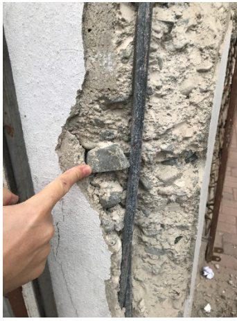
d) Granülometri dışı agrega ve yetersiz aderans
